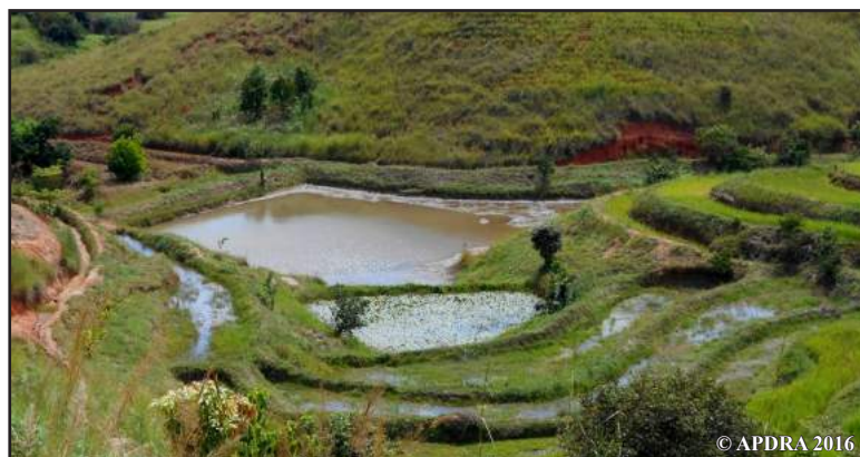
Type I : - Etang barrage avec les coteaux abrupts (sur la photo). - Etang barrage et dérivation lorsque les coteaux sont en pente douce.
