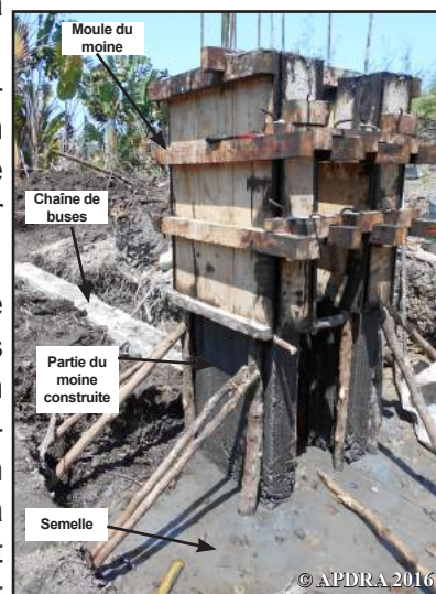
Construction du système de vidange
