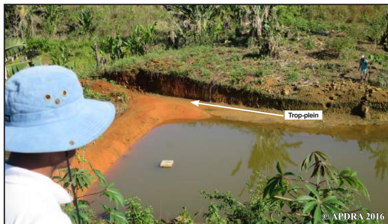
Le trop-plein vu d'en haut
