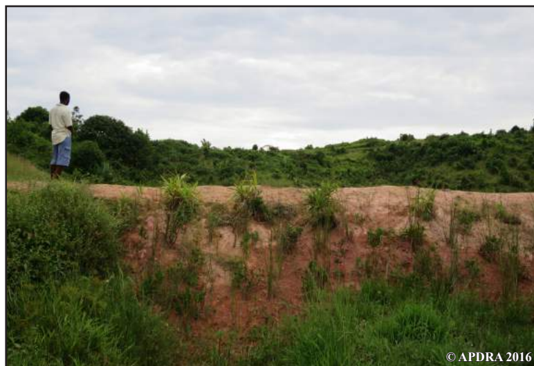
Plantation de vétiver sur la pente externe pour protéger la digue contre l'érosion
